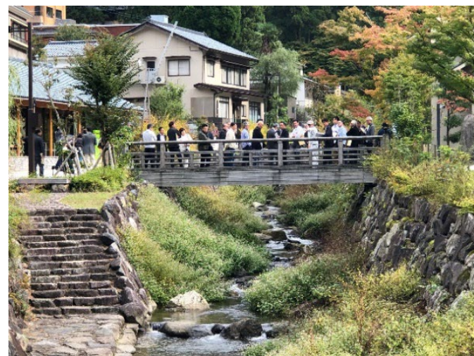
【改修後の永平寺川】
