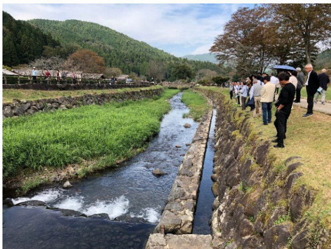
【石積沿いに朝倉館跡（堀）への導水路を整備】
